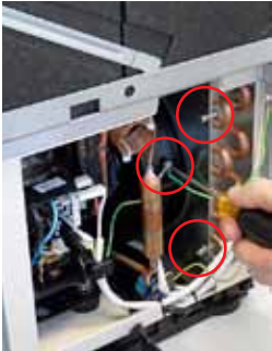
Step 2: Buka kabel ground dan buka 2 sekrup di atas.
